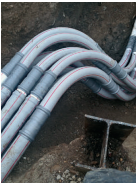
Rohrpaket Unterstossung SBB Gränicherstrasse
