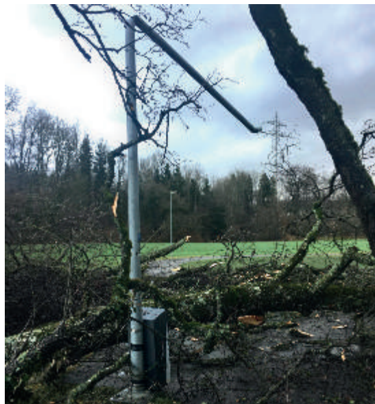
Sturmschaden Strassenbeleuchtung Januar 2018
