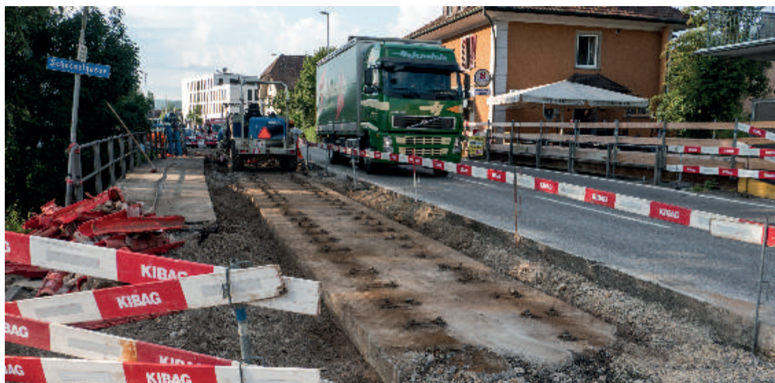
Suhrebrücke mit Fundament des alten WSB-Trasse
