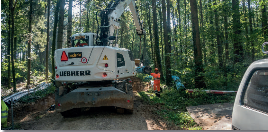
Rohrverlegung im Wald
