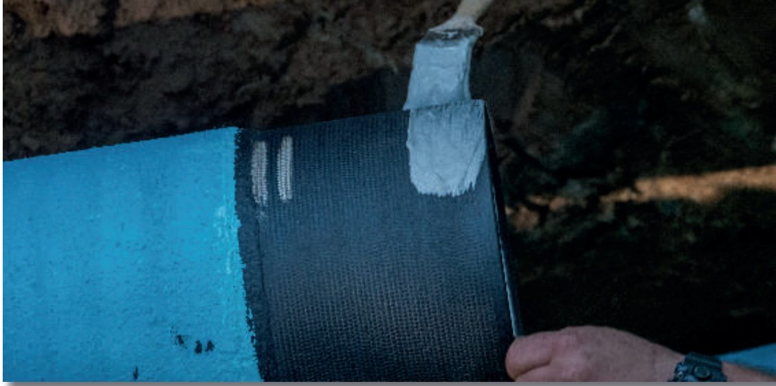
Vorbereitung der Rohrverbindung
