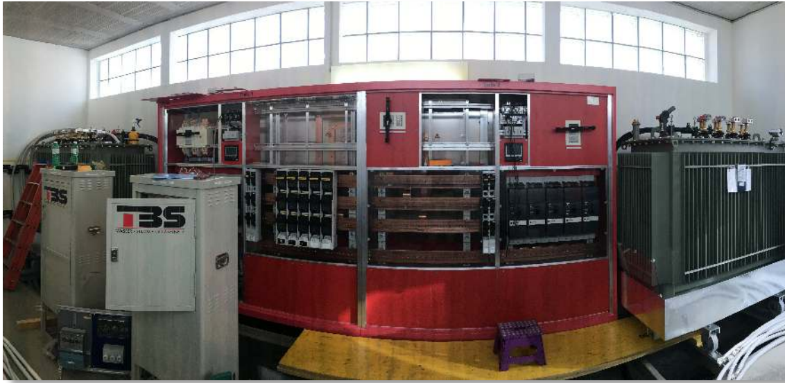
Umbau TS Gränicherstrasse
