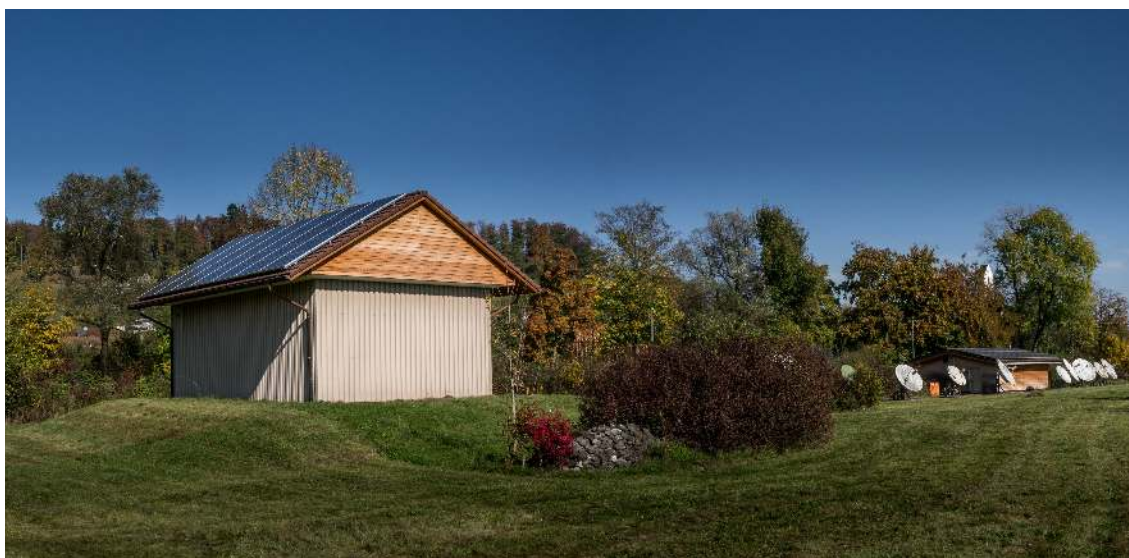
Grundwasserpumpwerk und SAT-Station
