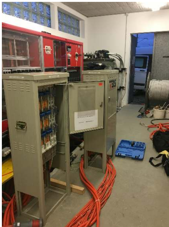
Vorbereitungen Sanierung TS Gränicherstrasse
