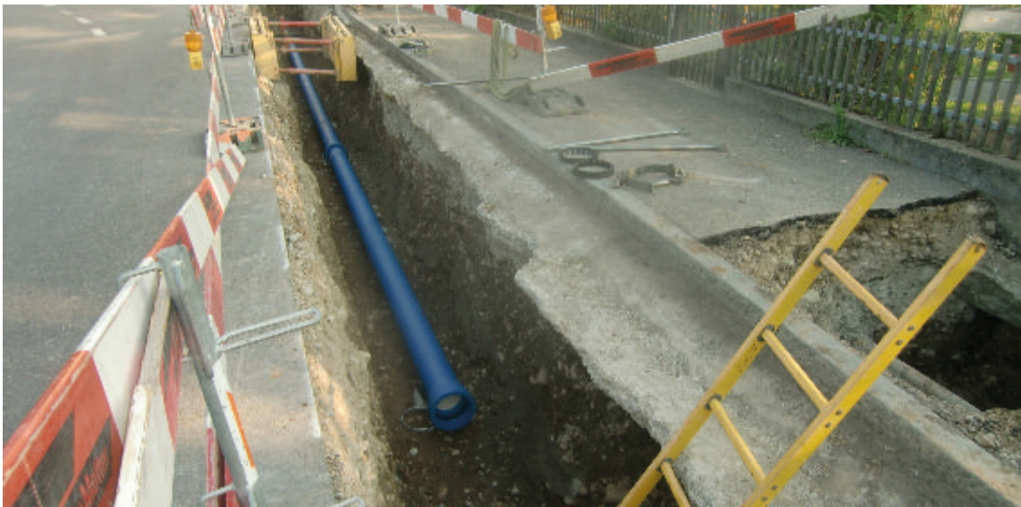
Neue Wasserleitung Mattenweg
