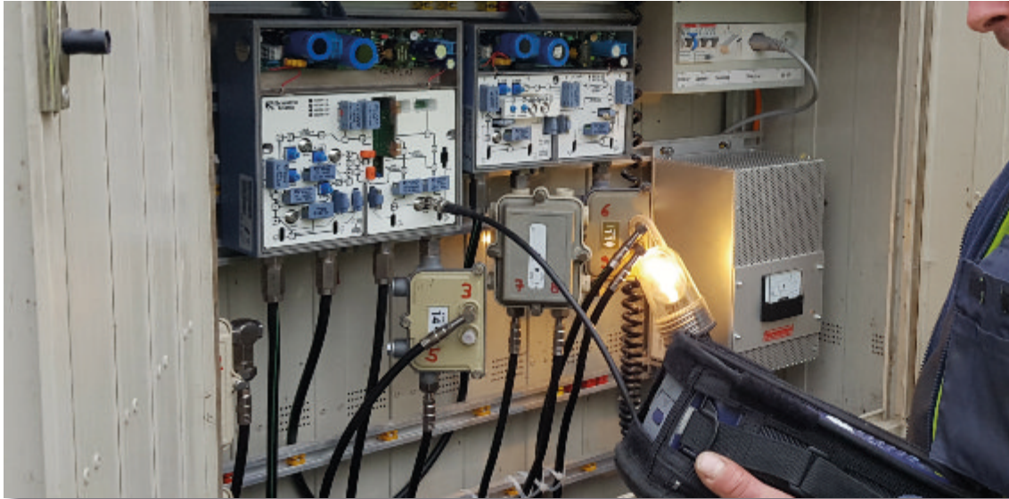
Pegeleinrichtung in temporärer TV-Verteilkabine
