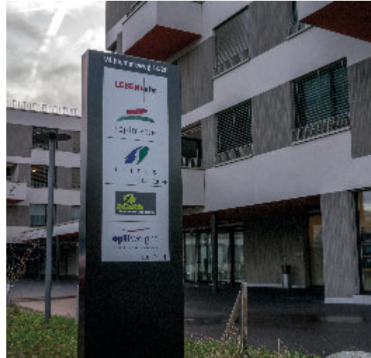
Baugenossenschaft LEBENSuhr mit Fernwärme
