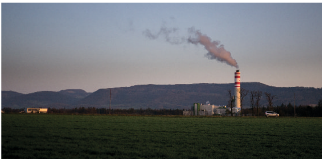
KVA Buchs, die zuverlässige Wärmequelle
