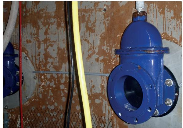
Mündung eines Fassungsrohrs
