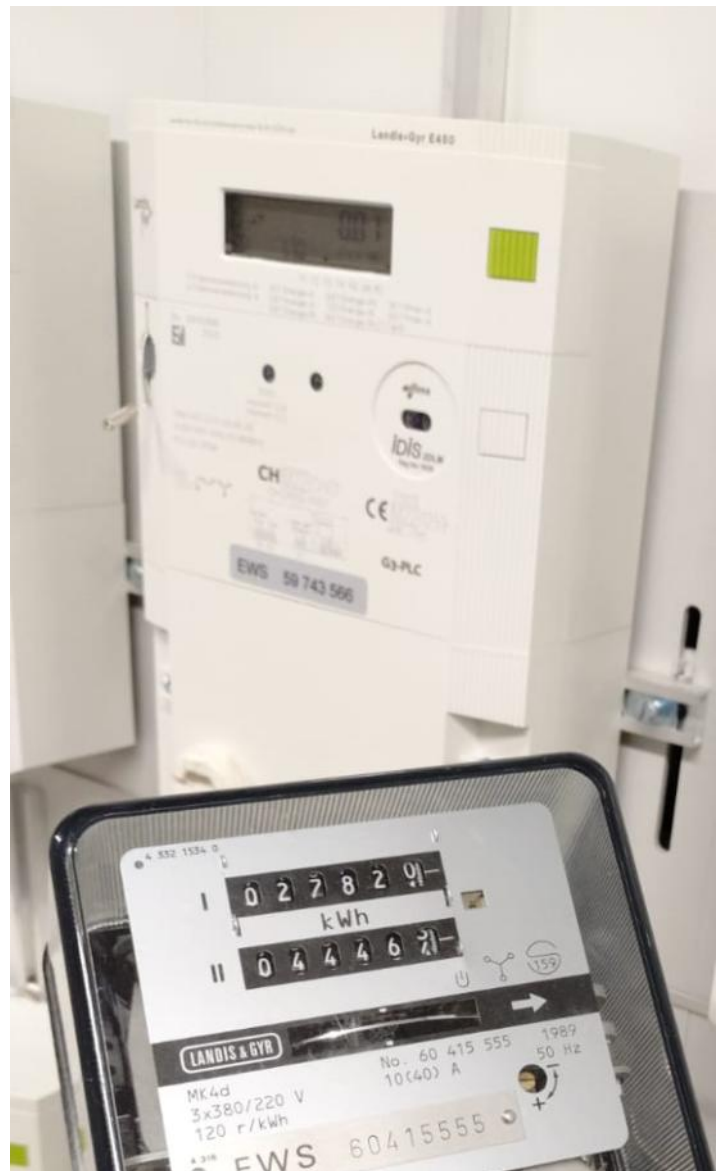
Ersatz eines konventionellen Stromzählers durch einen Smartmeter
