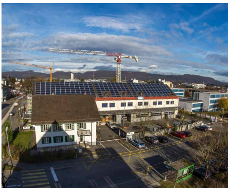
Eine der sieben Photovoltaikanlage befindet sich auf dem Dach des TBS-Gebäudes.
