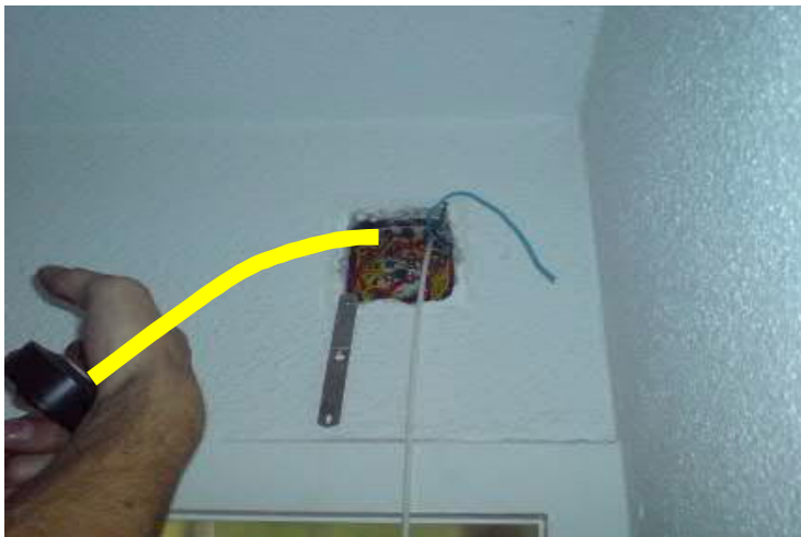
Beispiel: Erschliessung über Allgemeinteil "Starkstrom" im Treppenhaus
