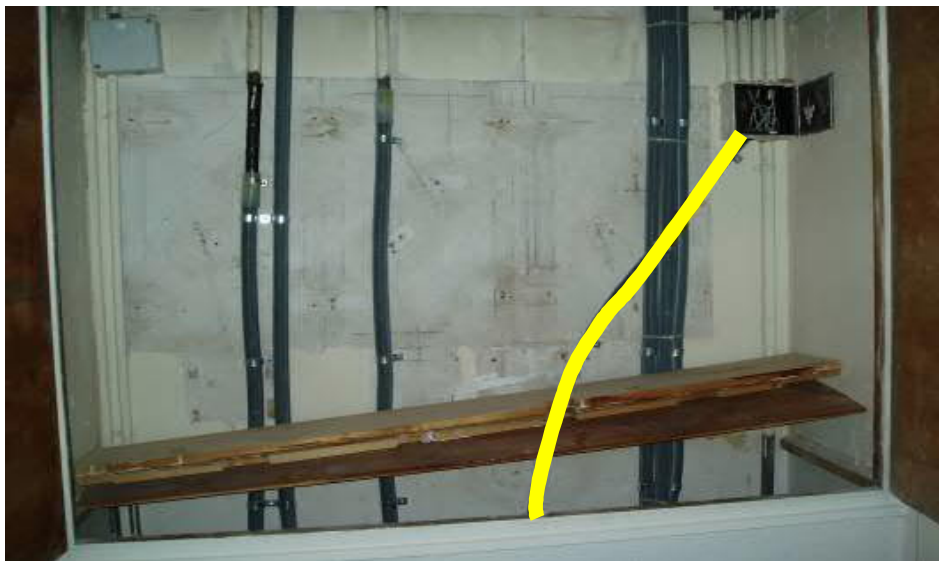
Beispiel: Einschlaufen über Telefonabzweigdose
