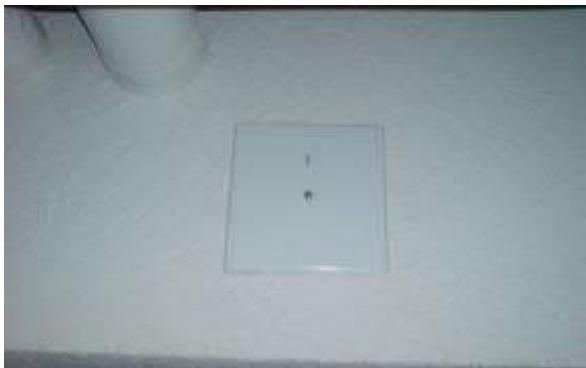
Beispiel: Einschlaufen über Sonnerieabzweigdose Treppenhaus
