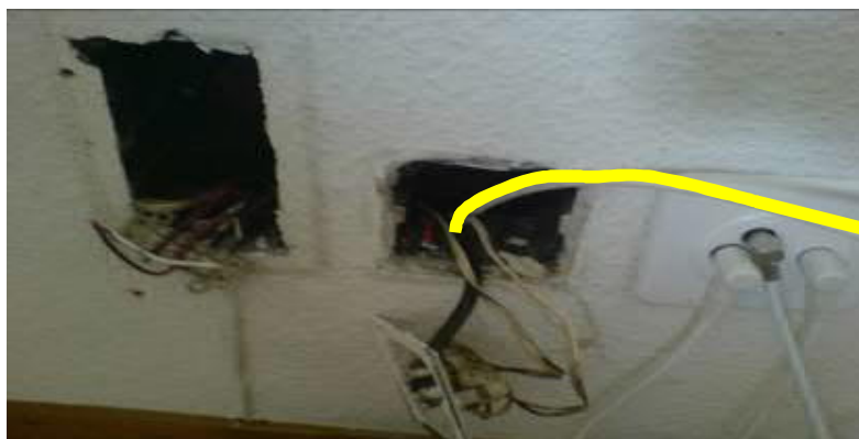
Beispiel: Einschlaufen über Telefonabzweigdose
