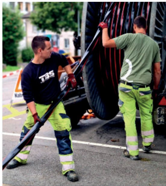
Einzug Mittelspannungskabel
