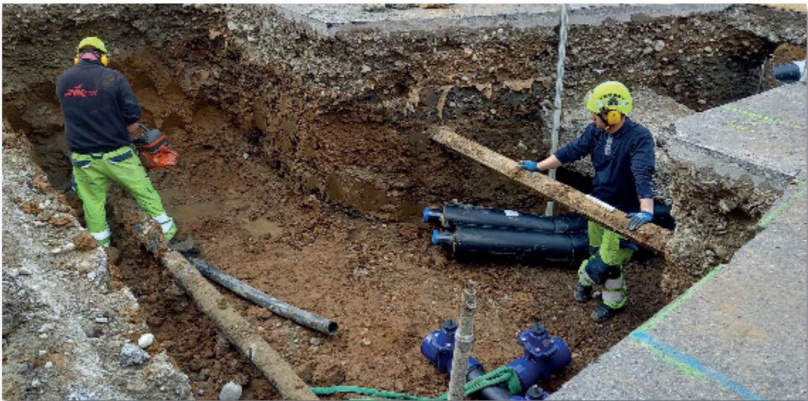
Sanierung Wasserleitung Zollweg
