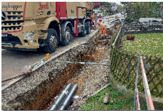
Bau Fernwärmeleitung Zollweg
