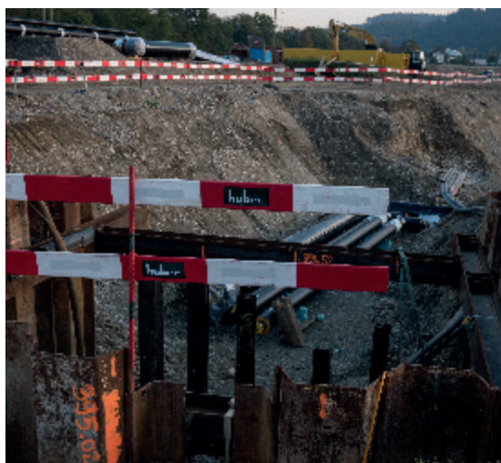
Bau der Dampf- und Heisswasserleitung FEWAG
