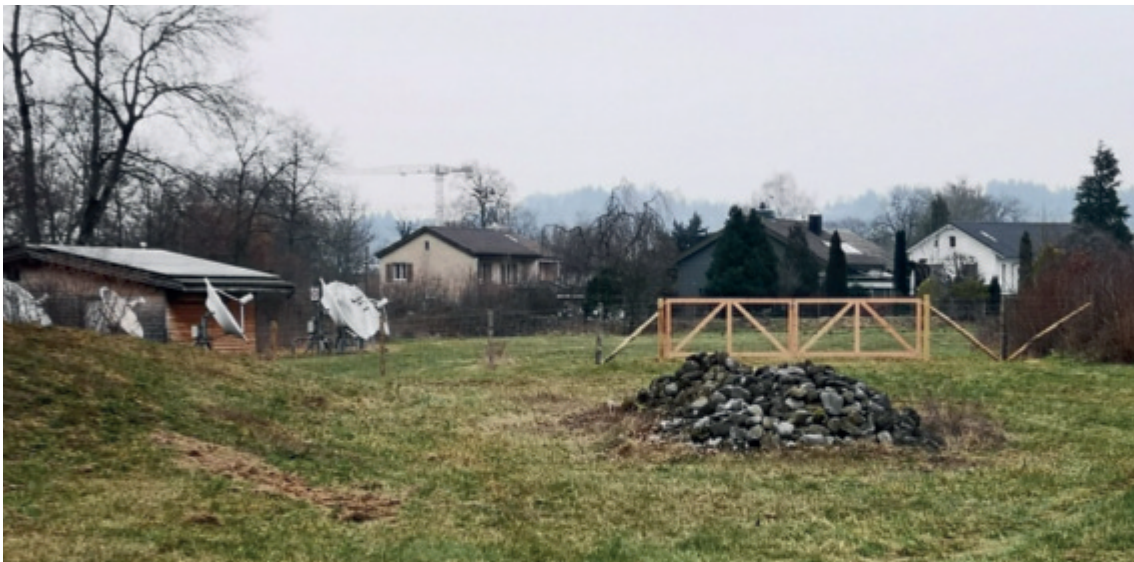
Neue Umzäunung Pumpwerk Distelmatte
