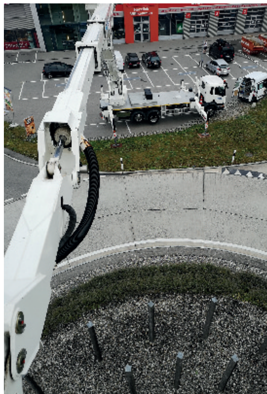
Reparatur Strassenbeleuchtung Kreisel Ausserdorf
