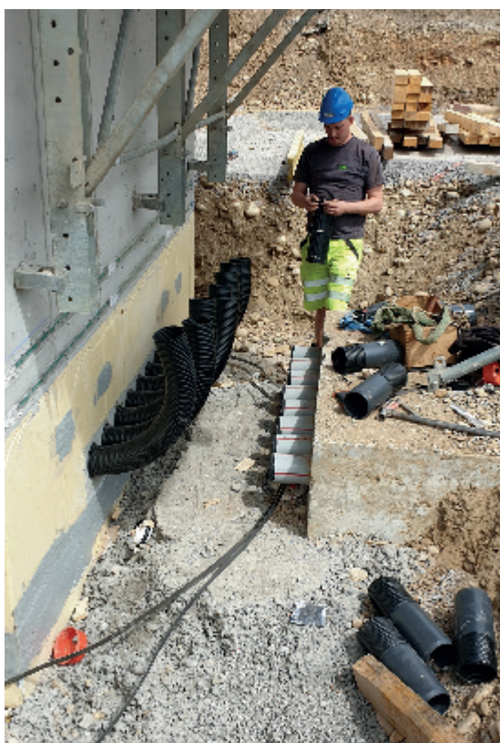
Bau der Rohreinführung TS Mitteldorf
