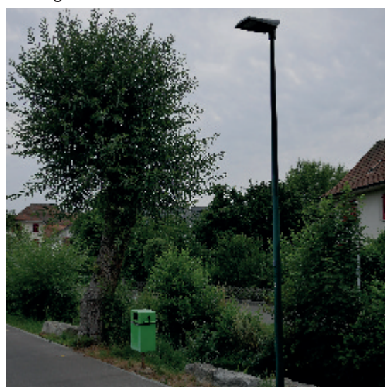
Umgebaute Strassenlampe im Aarauerfeld
